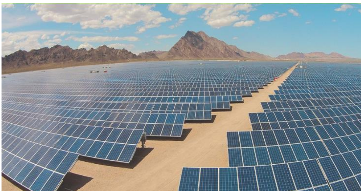
Figura 2.9 Parque Solar Fotovoltaico en Charanka, Gujarat, India
