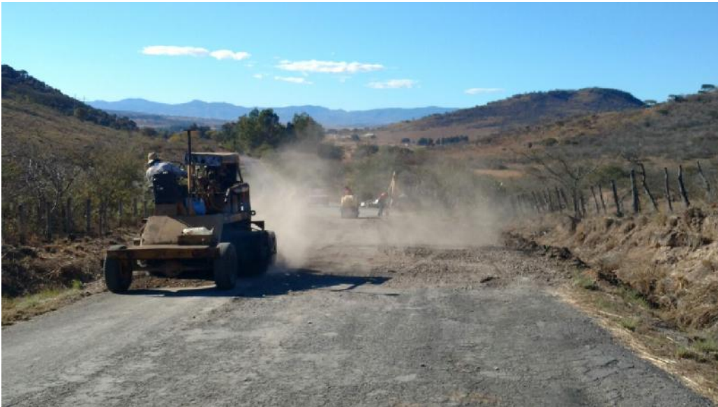
Fotografía 1, Trabajos Conservación Tecolotlán- Tenamaxtlán- Soyatlán del Oro
