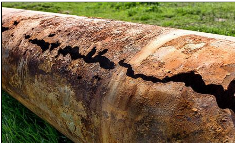
Figura 4.10 Tubería deteriorada por corrosión Fuente: Tomada de https://www.infocorrosion.com/index.php/infocorrosion-vip/infocorrosion-recomienda/item/1247-la-importancia-de-la-ingenieria-en-corrosion
