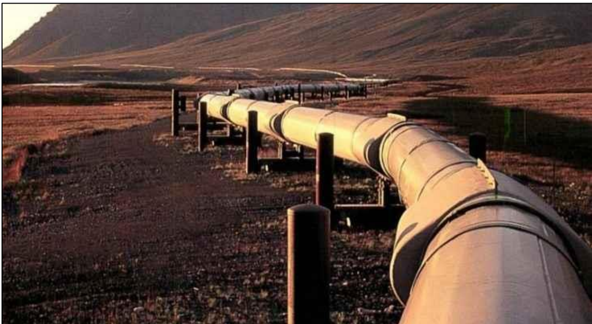
Figura 3.5 Gasoducto Topolobampo en Sinaloa. Fuente: Tomada de https://centrourbano.com/2018/07/19/construyen-gasoducto-chihuahua-sinaloa/
