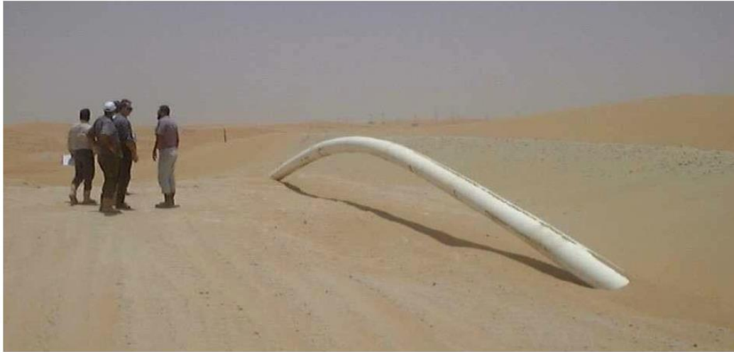
Figura 4.9 Doblez en tubería expuesta a altas presiones y temperaturas Fuente: Tomada de H Saadawi, Upheaval Buckling of Gas Injection Pipelines Onshore Abu Dhabi - A Case Study, Society of Petroleum Engineers Marzo 2001
