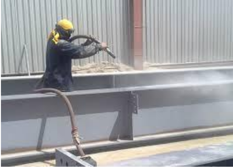
Figura 14, Sandblasteado de estructura, proceso de limpieza
