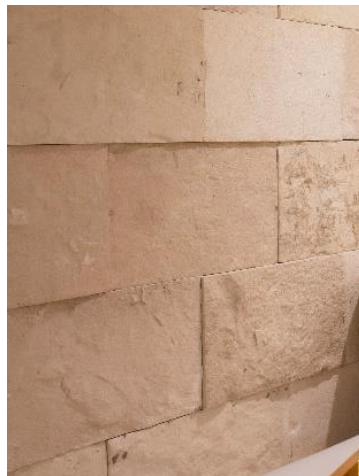
Figura 15, Muro cara de piedra galarza, acabado especial
