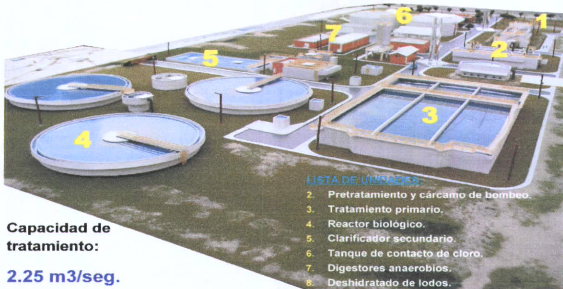
Figura.2.4 Planta de tratamiento "combinada", Tipo terciario, Proyecto conceptual: PTR "El Ahogado". Fuente de información: CEA.
