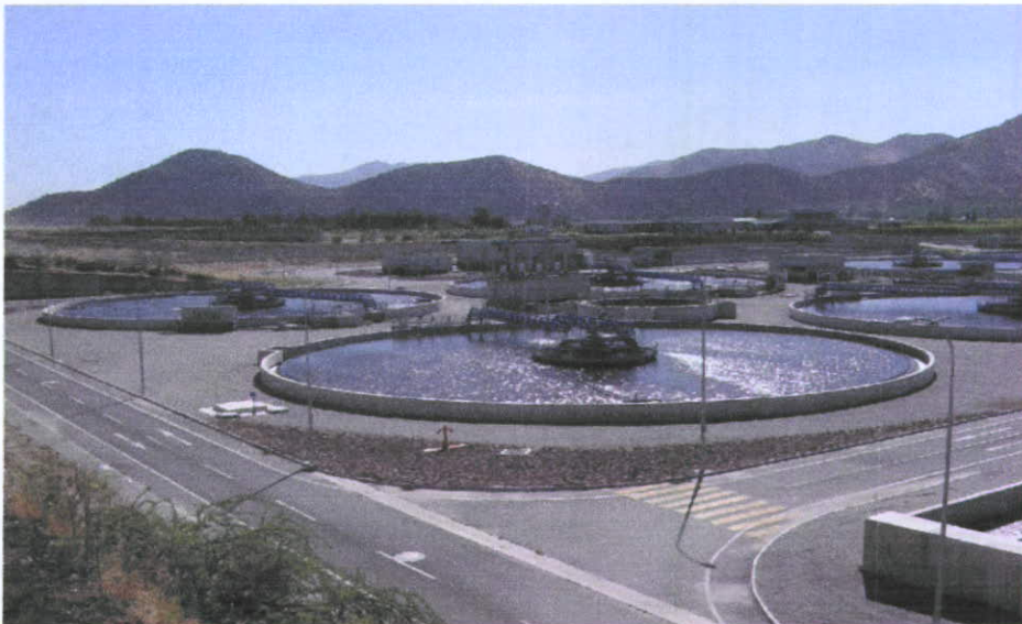
Figura.2.1 "Vista aérea" tanques aeración, planta de tratamiento "Rio Blanco", Mpio de Zapopan. Fuente de información SIAPA. Jalisco
